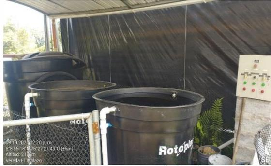
Imágenes relacionadas con el sistema de riego y preparación de agroquímicos de la zona de floración con ingreso de aguas lluvias (4 tanques prefabricados, con capacidad de 5.000 litros cada uno).
