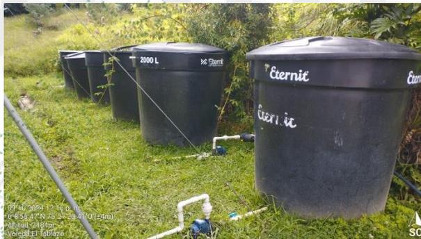
Las aguas lluvias direccionadas por las “cunetas artificiales” son recolectadas en los 5 tanques de almacenamiento prefabricados con capacidad de 2.000 litros cada uno. El sexto tanque es el encargado de distribuir el agua para el riego de las plantas madre.
