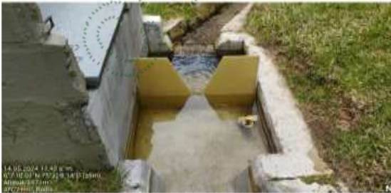
Imagen1. Obra de captación.
