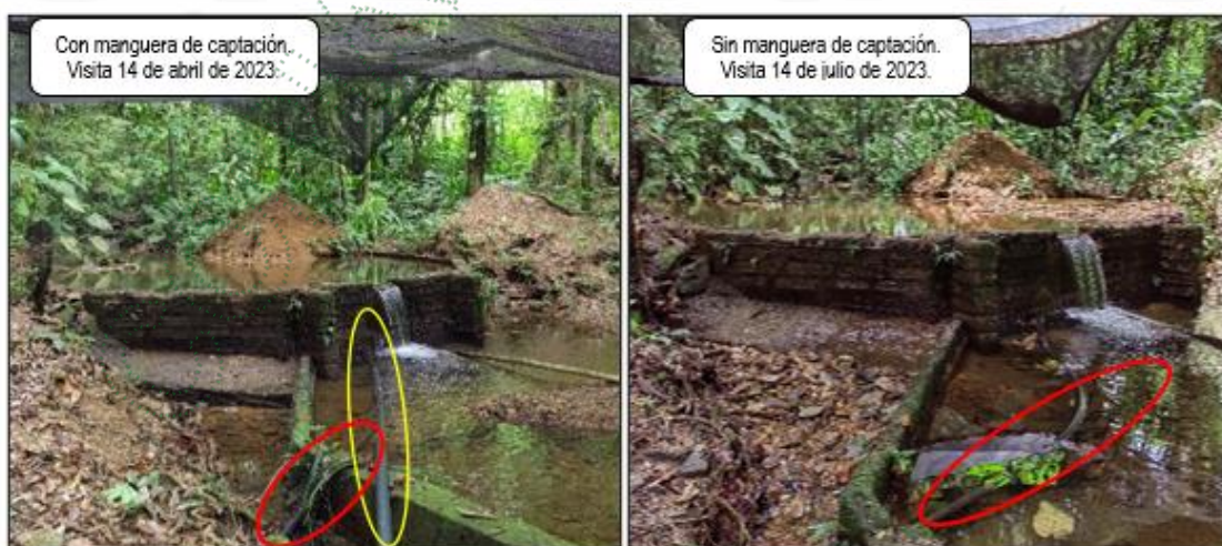
Imagen 1. Cornare. 2023. Presencia (izquierda) y retiro (derecha) de la manguera instalada por IACOL S.A.S., sobre la Quebrada Campo Godoy.
