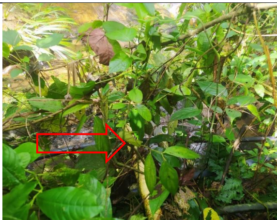
Figura 4. Tubería de descarga de ARnD del predio 1 a la Q. El Rosario.
