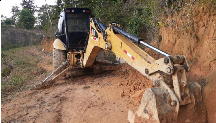
Maquinaria tipo retroexcavadora utilizada para el movimiento de tierra.
