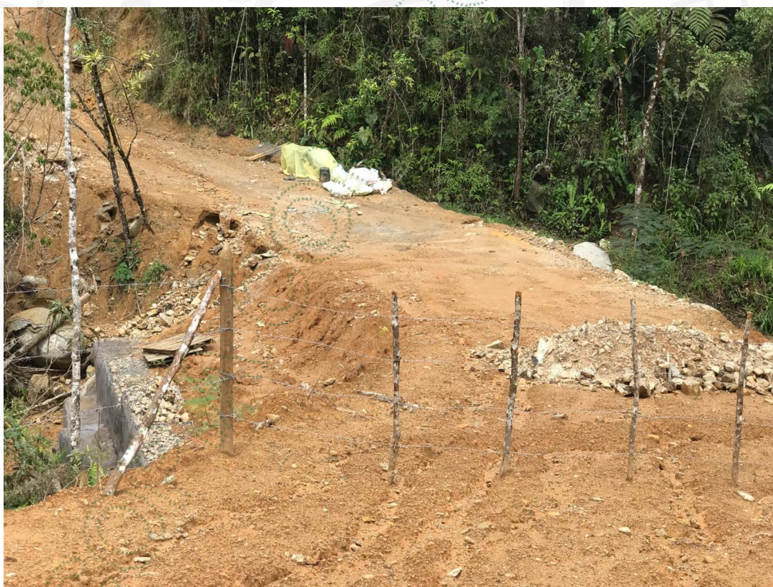
Figura 12. Obra de ocupación de cauce
