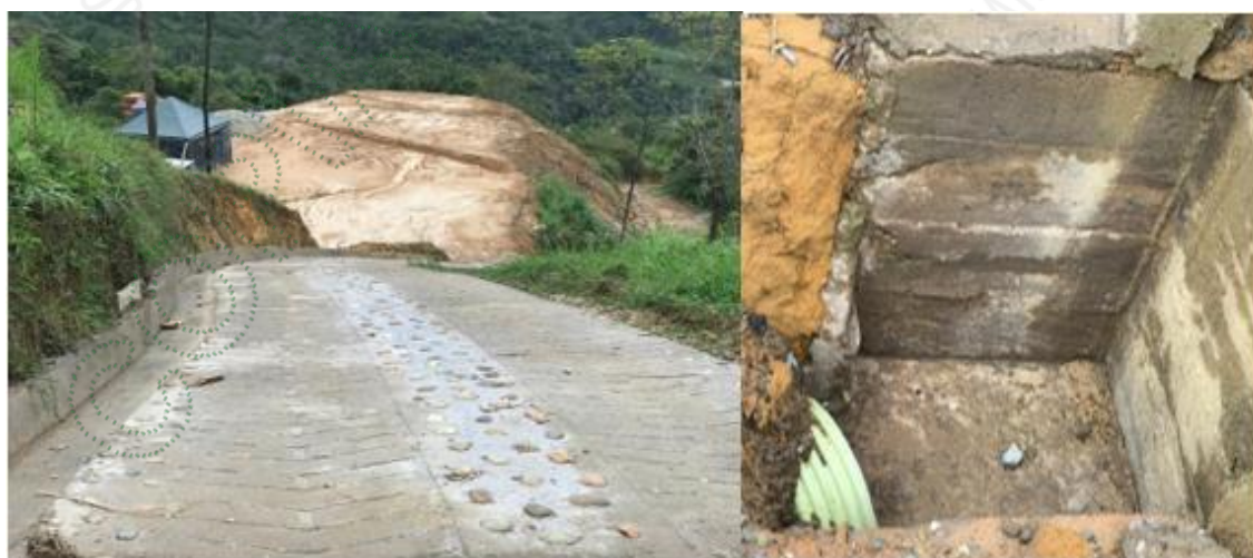
Figura 8. Inicio de vía interna y obra transversal
