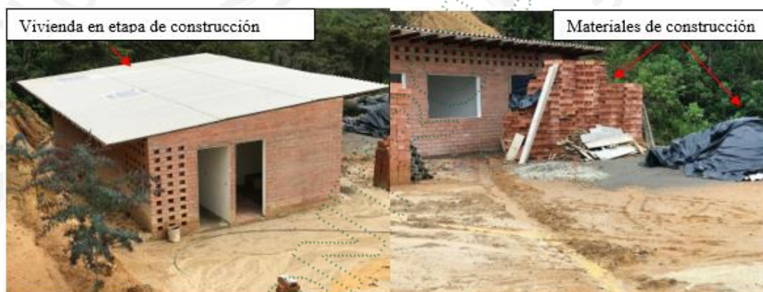
Figura 7. Vivienda en etapa de construcción
