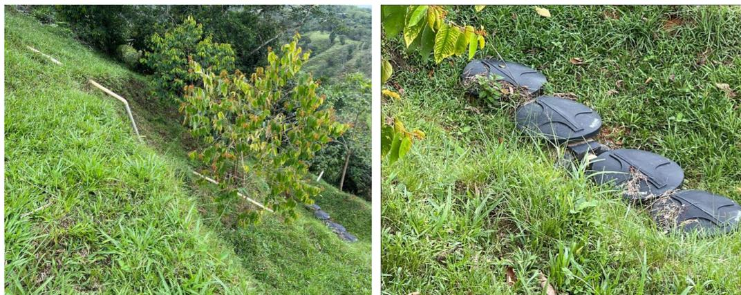
Foto 4 y 5. Tubería de conexión al tanque séptico, instalado para el proyecto “Glamping El Sueño”
