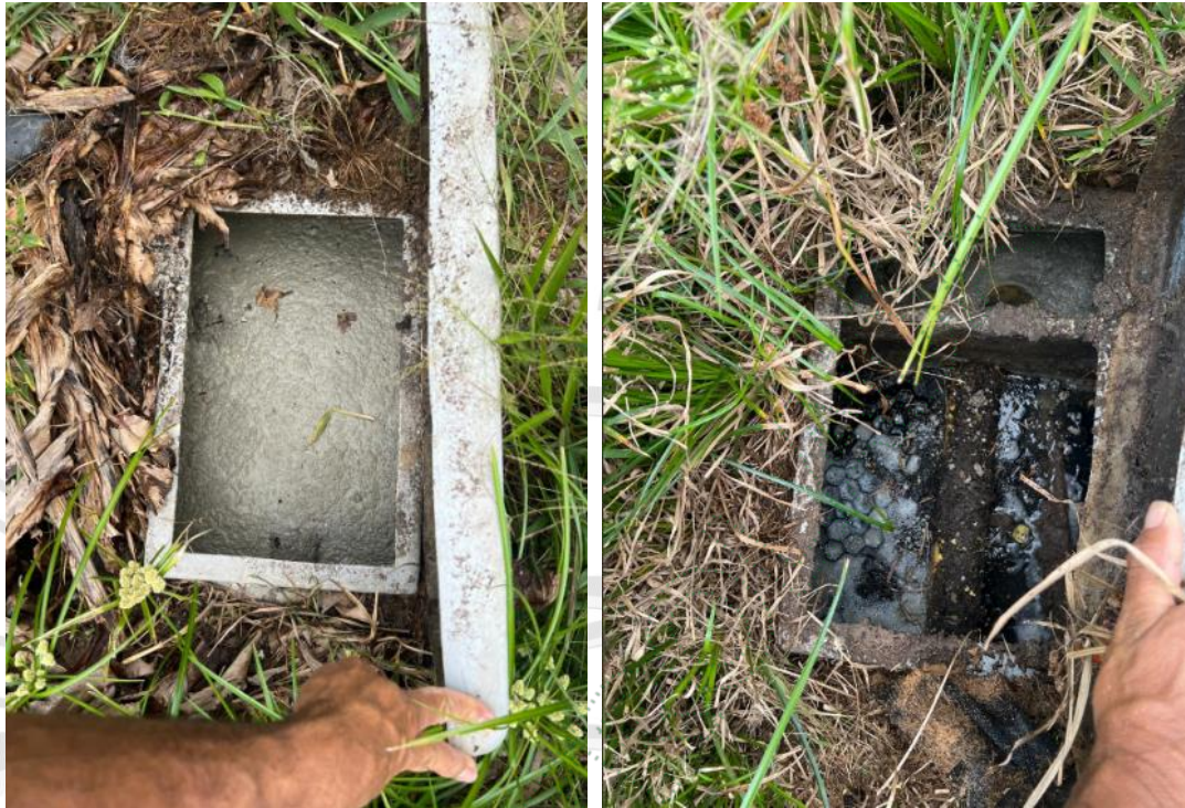
Foto 10 y 11, Tanque séptico del Establecimiento de Comercio La Devisa Cielo Azul. Fuente: Cornare 2024
