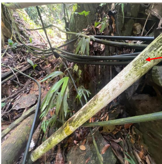
Foto 1 y 2. Mangueras de diferentes diámetros y tubería de PVC de 4" sobre el cauce de la quebrada La Corozal o Las Brisas
