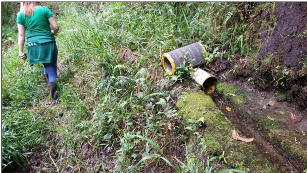
Foto 5. Mangueras de 8 pulgadas de diámetro conectando la acequia.
