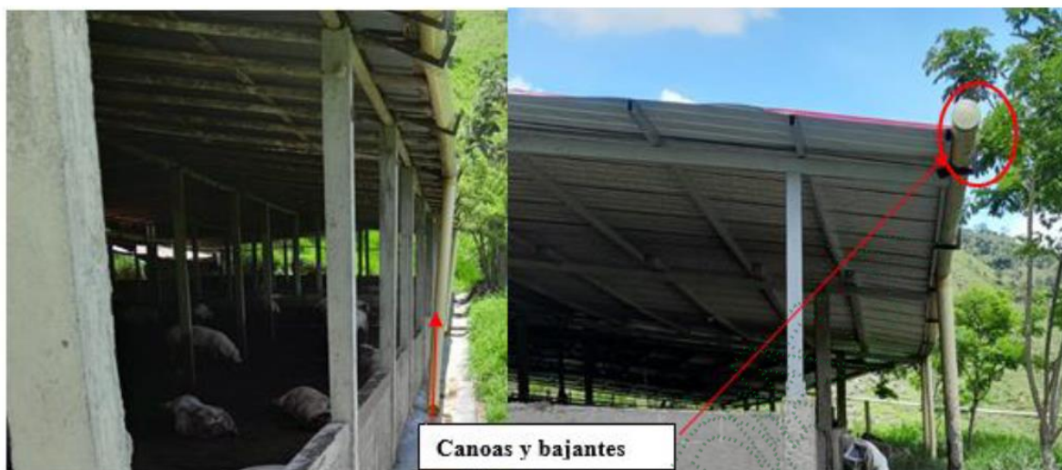
Figura 2. Instalación de canos y bajantes
