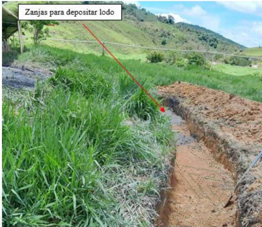
Figura 4. Zanja para depósito de lodos
