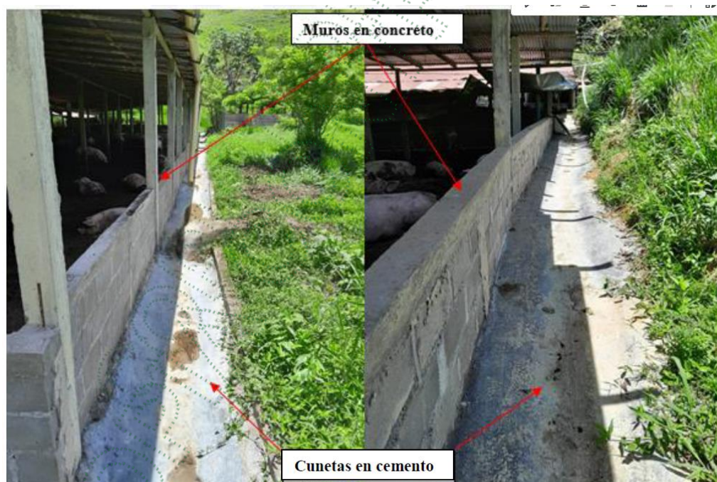
Figura 1. Adecuación de infraestructura
