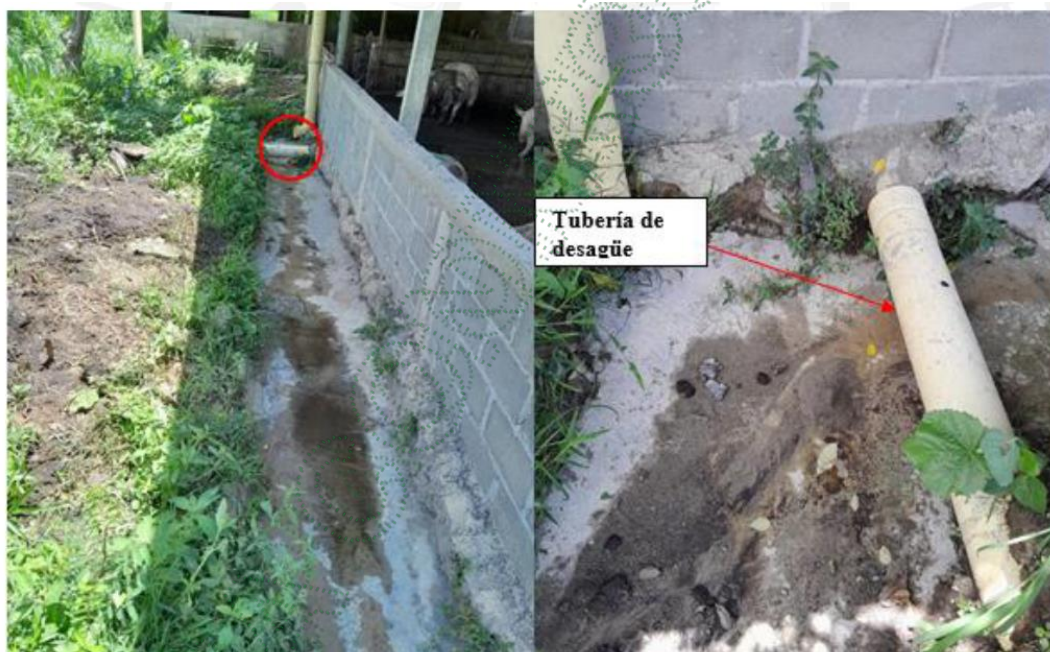
Figura 3. Instalación de tubería de desagüe
