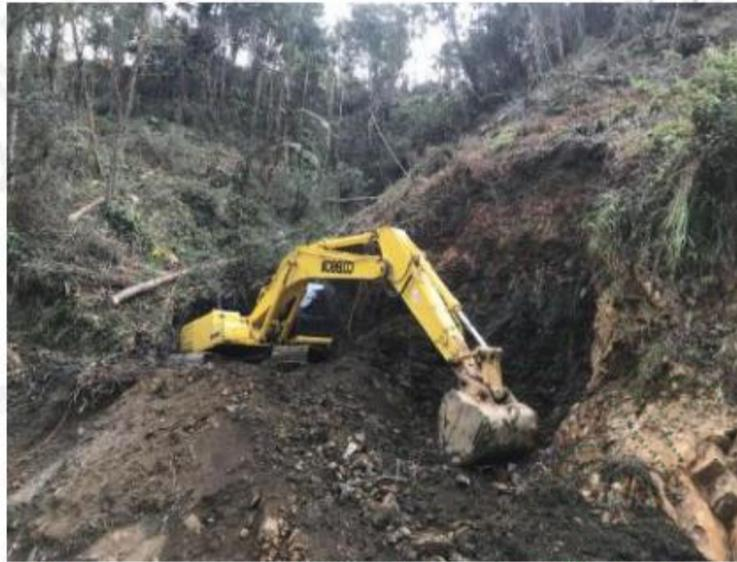
Foto 1. Apertura de vía por medio de retroexcavadora. Fuente. Cornare, 2024.
