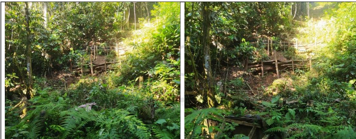
**Figuras 1 y 2.** Trincho 1 implementado para contención de sedimentos.
