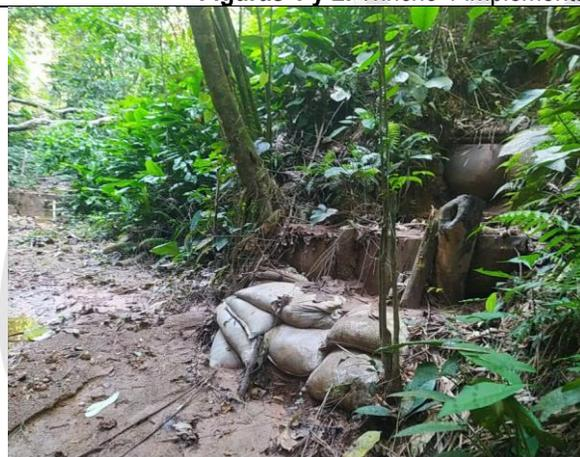
**Figura 3.** Trincho 2 implementado para contención de sedimentos
