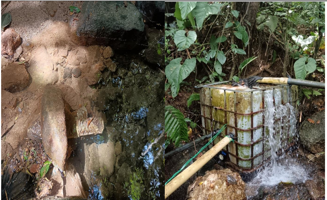
Fotografías 1 y 2: Sitio de captación de la fuente hídrica Sin Nombre y tanque de distribución
