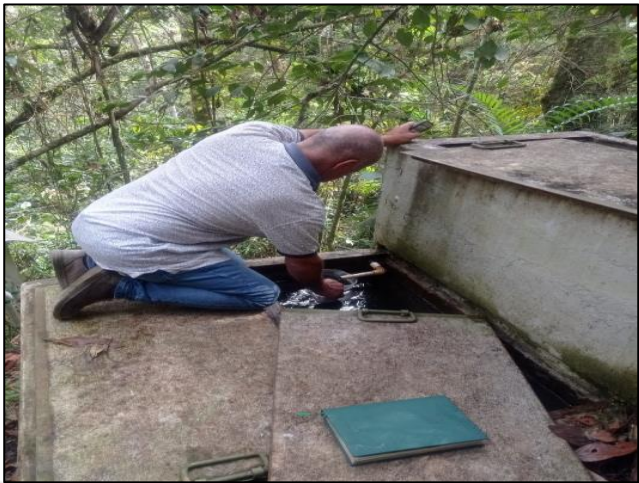
Figura 1. Obra de control de Caudal
