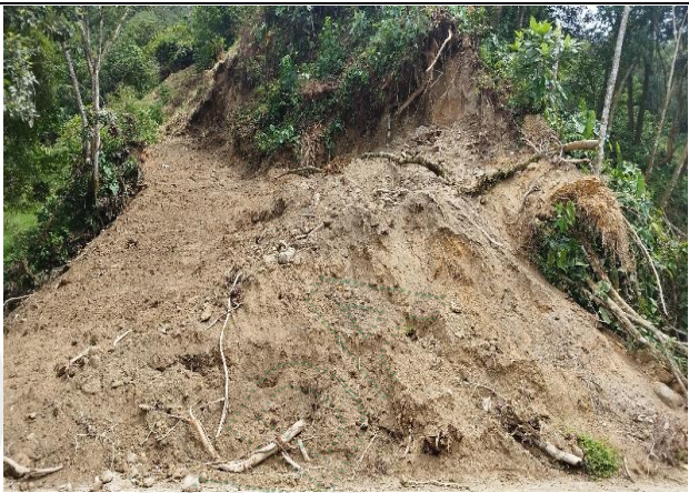
Apertura de vía
