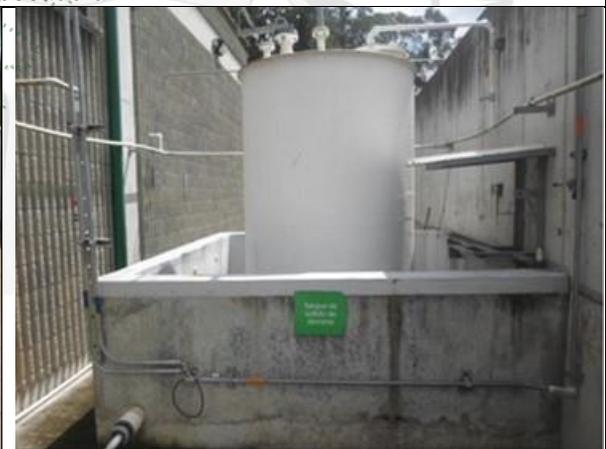
Tanque de dosificación de sulfato de aluminio
