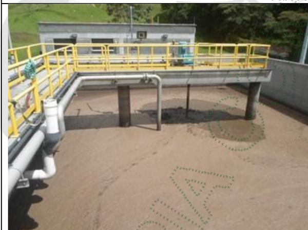
Digestor aerobio de lodos
