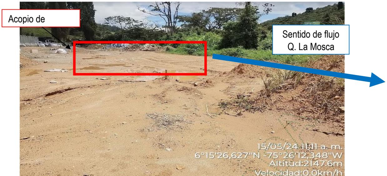
Con el material depositado se genera un cambio en las condiciones hidráulica de la Quebrada ante las crecientes. Obstruye el libre escurrimiento de agua redireccionándola a la otra margen de la fuente, y ocasionando aumento de la lamina de agua y velocidad que conllevan a afectación a los predios vecinos.
