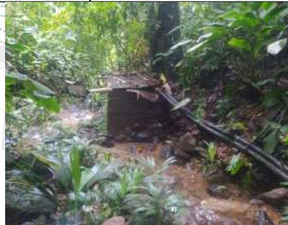
**Figura 8. Tanque de abastecimiento y desarenador del predio 7.**
