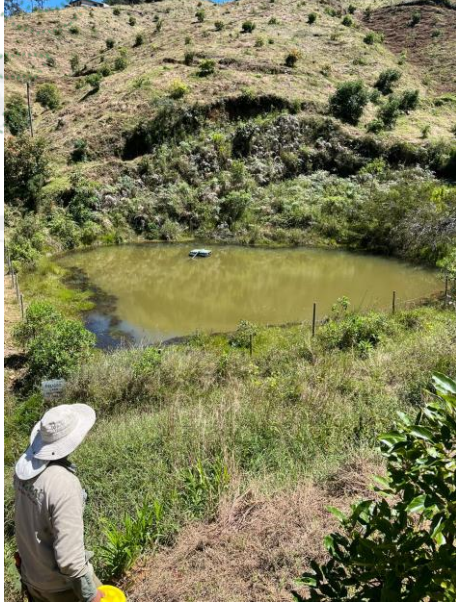
Imagen 4. Reservorio de almacenamiento
