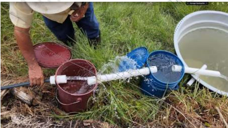
Obra de control de caudal que no cumple con los diseños recomendados por Cornare y ubicada cerca al tanque de almacenamiento sin control de flujo, en este punto la obra de control de caudal no cumple su función
