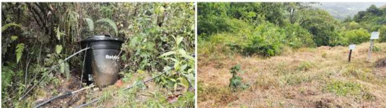
**Taque instalado después de la captación artesanal con el sobrante sobre la fuente, sitio de donde fue retirado el tanque que generaba procesos erosivos**
