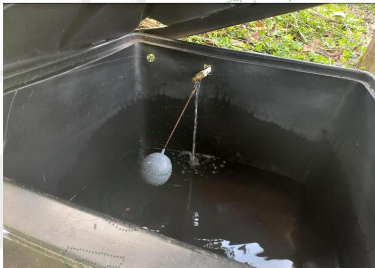
**Imagen 3.** Instalación de dispositivo de control de flujo en tanque de almacenamiento
