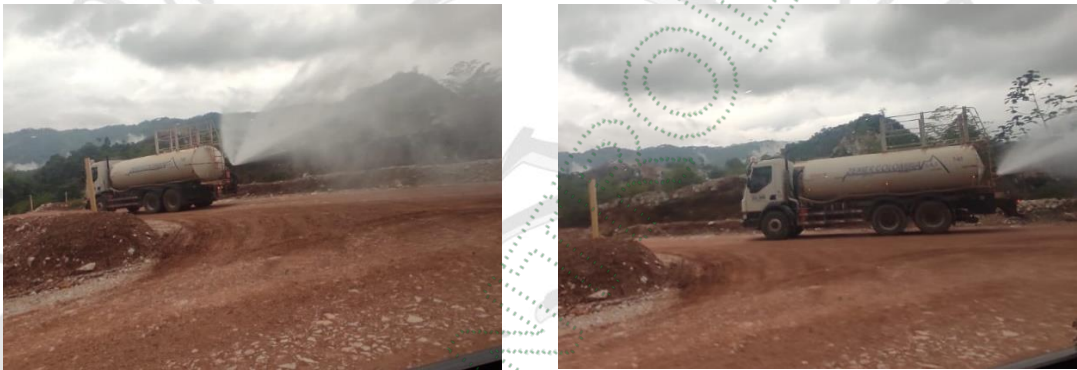
Fotografía 1. Humectación vías internas del proyecto Fuente: Cornare, 2024.
