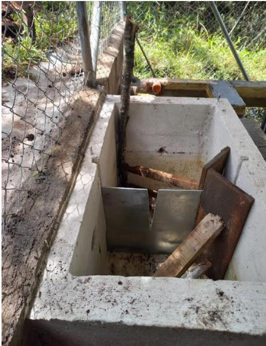
Imagen 3. Obra de control en construcción
