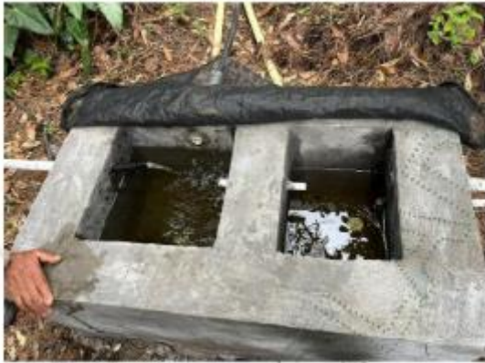
Imagen 2. Obra de captación
