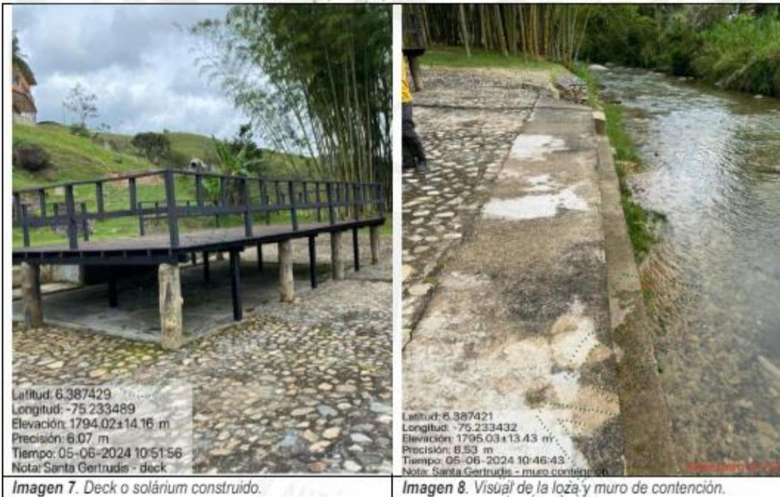
El señor Albeiro García, indica que la loza y el muro de contención se construyeron con el fin de frenar la socavación del lote y la erosión del suelo, como medida de prevención a los impactos ocasionados por la corriente del río Concepción.
