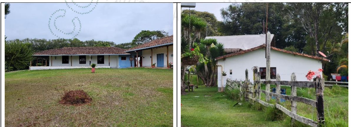
Viviendas existentes (Principal, mayordomo y cuarto util)
