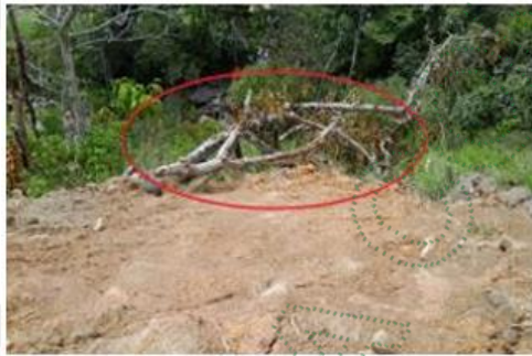
Imagen de árboles talados sobre la vía construida.
