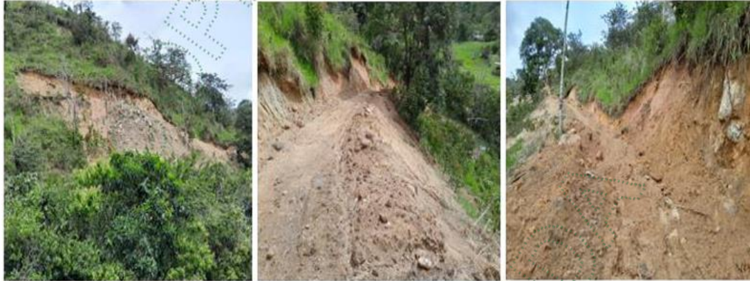
Foto 1: Movimientos de tierra para la apertura de vía. Fuente Cornare 2024
