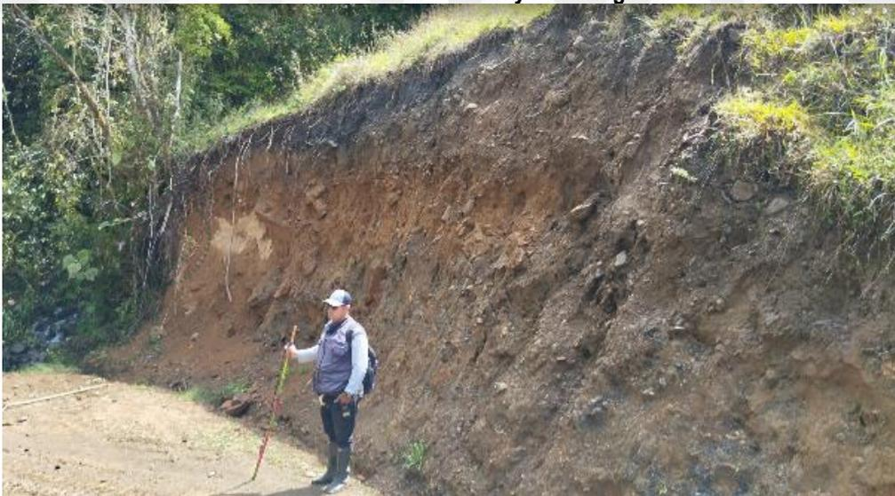
**Uno de los taludes generados con más de 3 metros de altura y una pendiente de 90°**
