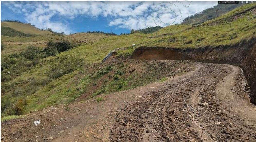
**Material estéril sobre las laderas y taludes generados**
