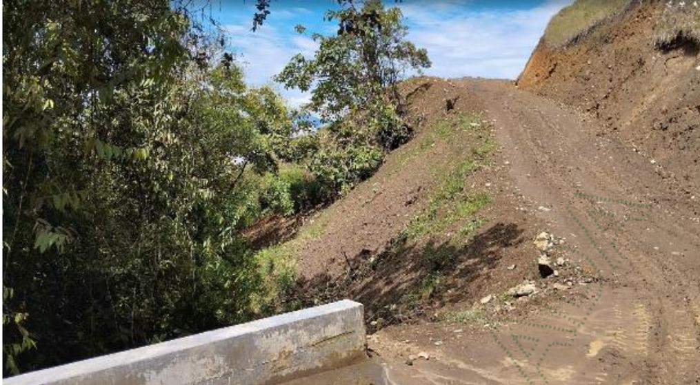
**Relicto de bosque intervenido para la construcción del Box culvert, taludes y estériles depositados en las laderas**
