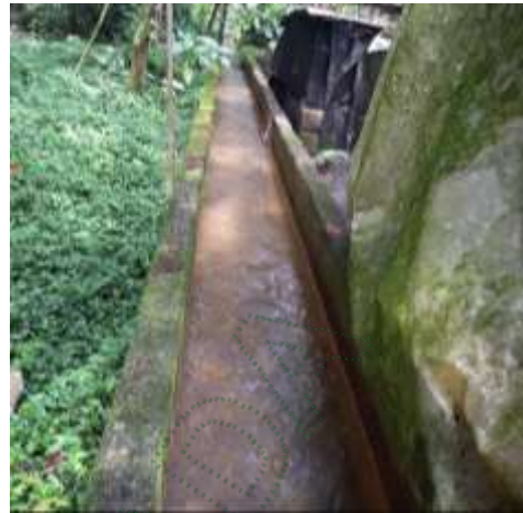
Imagen 2. Canal de conducción.
