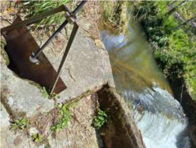
Imagen 1. Obra de captación
