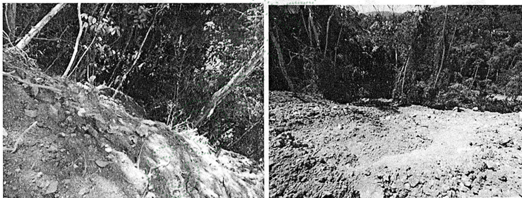
Fotografía 3. Material de apertura de vía interna dispuesto en la ladera
