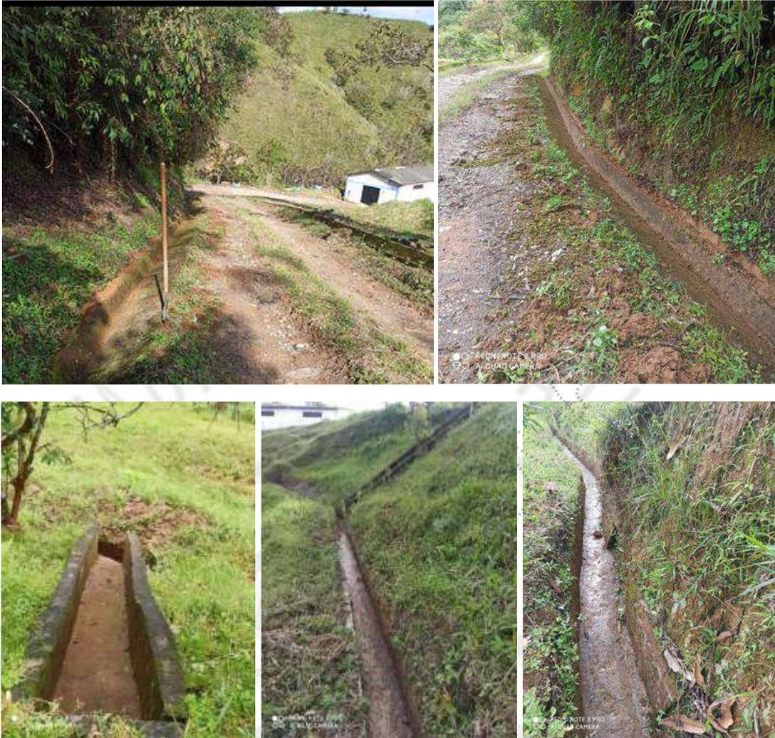
**Ilustración 3: Mantenimiento de cunetas**
