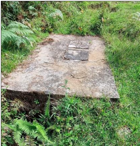
2. Tanque de reparto.
