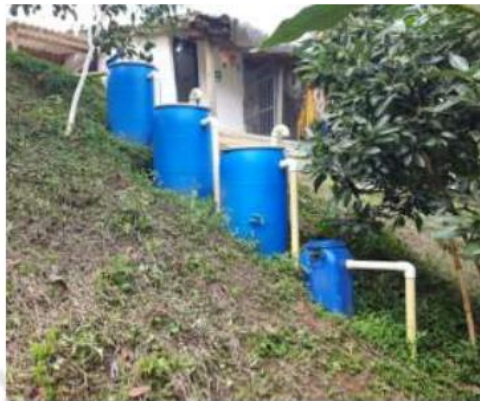
Pozo de desactivación con descarga a suelo Fotografía 1: Zona de inmersión, lavado de implementos de trabajo y pozo de desactivación con descarga a suelo. Fuente: Cornare. 2024.
