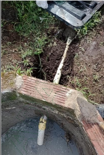
JUNIO 2024 - CONEXIÓN REALIZADA AGUAS GRISES A SISTEMA SÉPTICO
