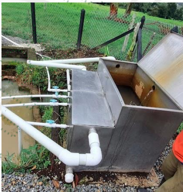
Imagen 11. Obra de reparto
