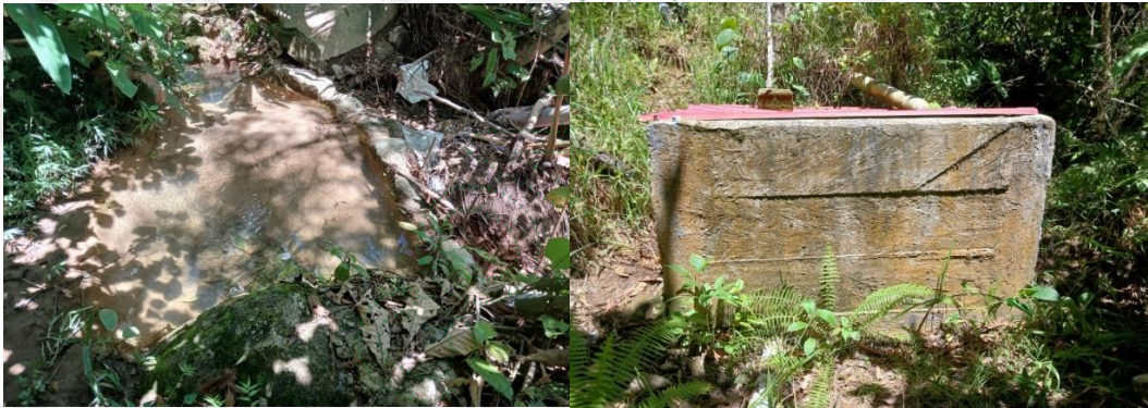
Figura 7. Obra de captación artesanal, tanque de almacenamiento en la fuente.
