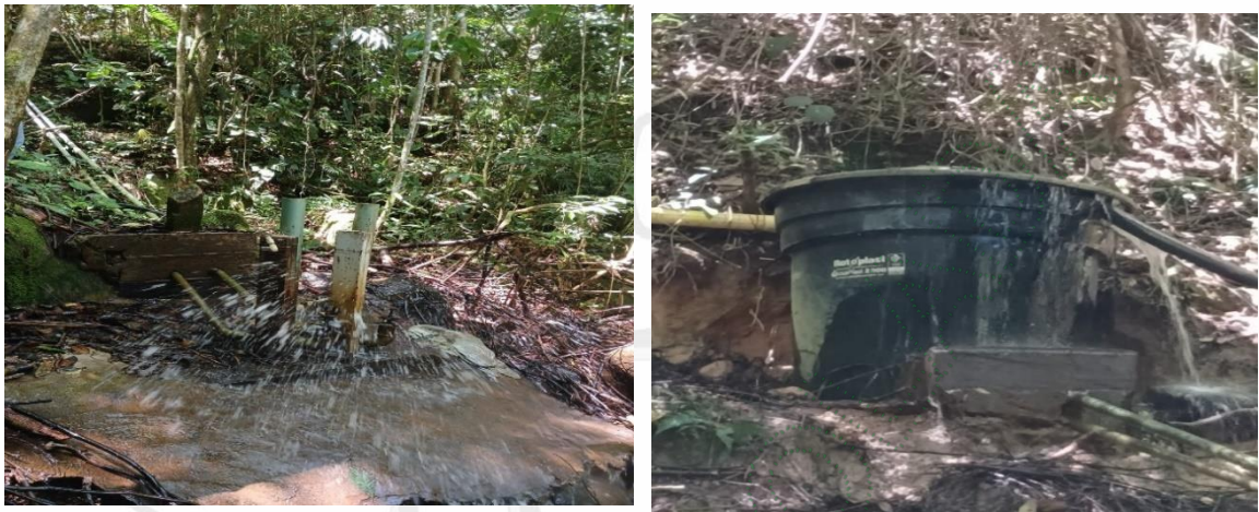
Figura 8. Obra de captación artesanal, y tanque de almacenamiento.
