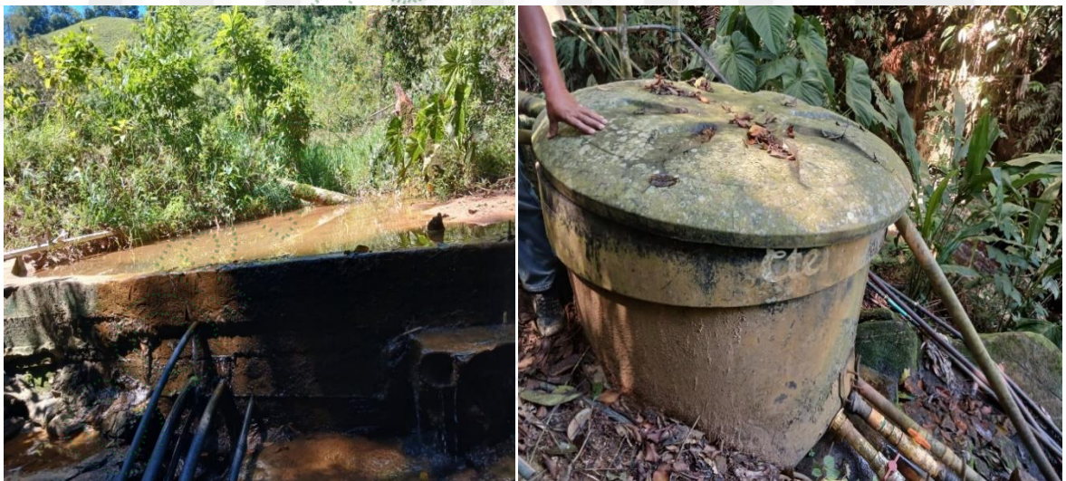
Figura 9. Obra de captación artesanal, y tanque de almacenamiento
