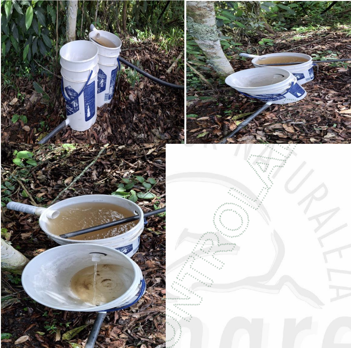
Obra de control de caudal
