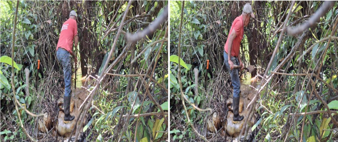
Limpieza en el sitio de la captación
