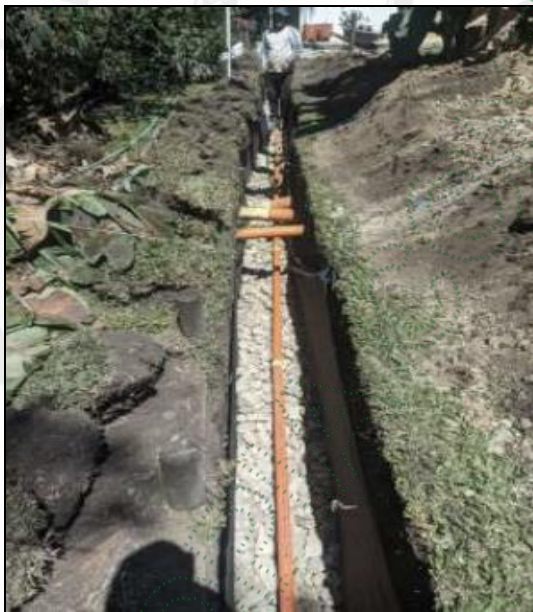
Imagen 1. Tomado de correspondencia de entrada CE-02068-2024. (2024). Adecuaciones estructurales en campo de infiltración, Rionegro.
