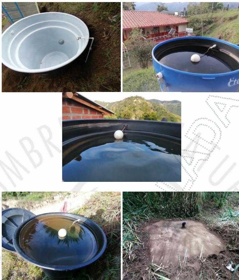
**Tanques de almacenamiento con dispositivos de control de flujo y pozos sépticos.**
