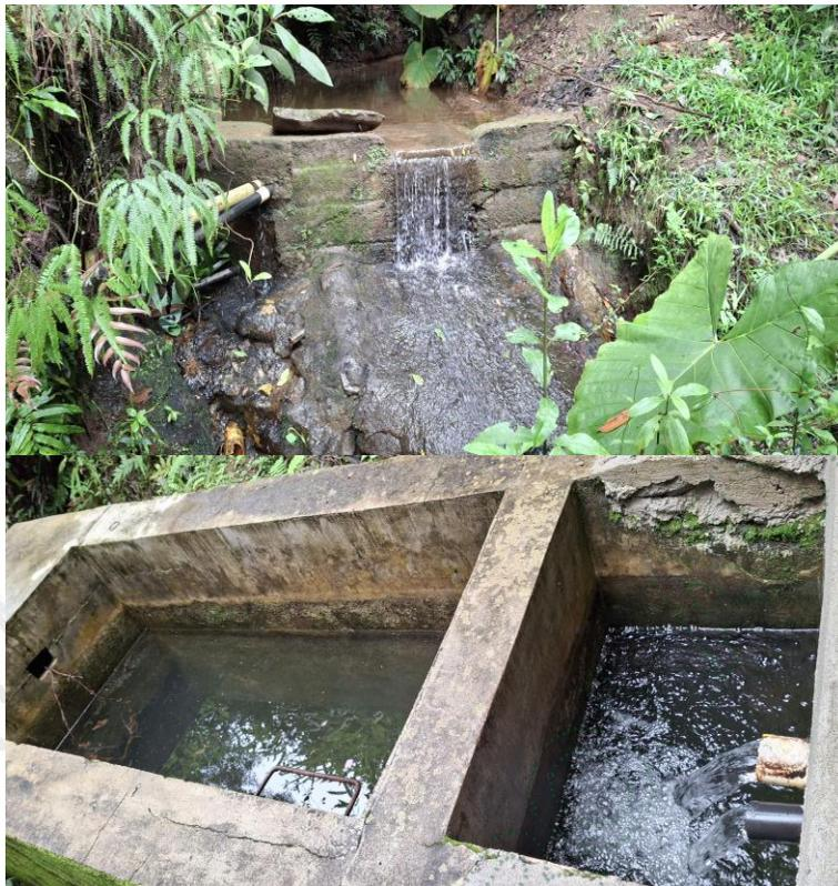
**Obra de captación y tanque desarenador**
