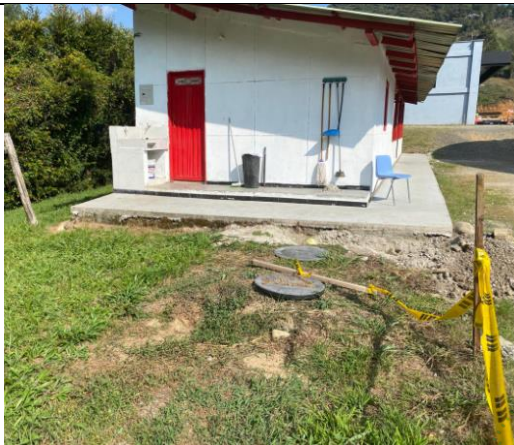
Sistema de tratamiento de ARD
