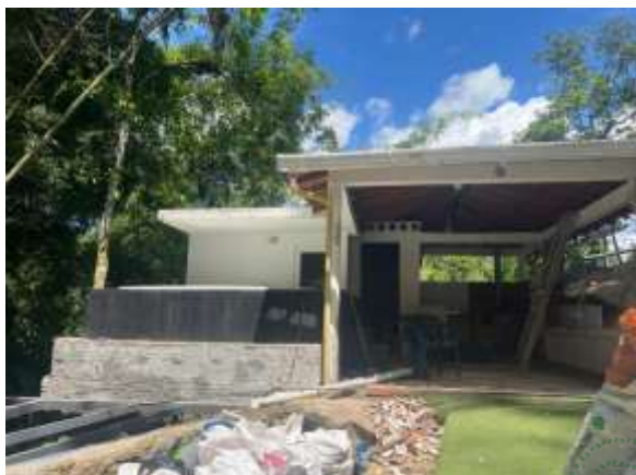
Fotos 5,6 y 7. Estructura metálica para la conformación de un Deck que complementa el quiosco. Fuente Cornare 2024.
