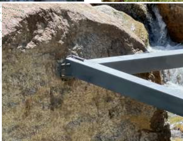
Foto 8, 9 y 10. Estructura metálica sobre el cauce la quebrada “sin nombre”. Fuente Cornare 2024.
