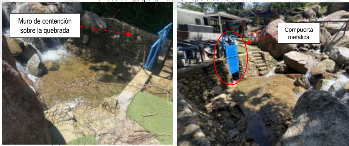
Foto 1 y 2. Muro en concreto recubierto en roca sobre el cauce la quebrada “sin nombre”. Fuente Cornare 2024.
