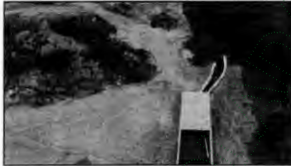
Imagen 3. Sedimentador construido en el predio, que recibe las aguas de los canales de aguas de escorrentía, previo a la entrega del agua clarificada a la fuente hídrica.
