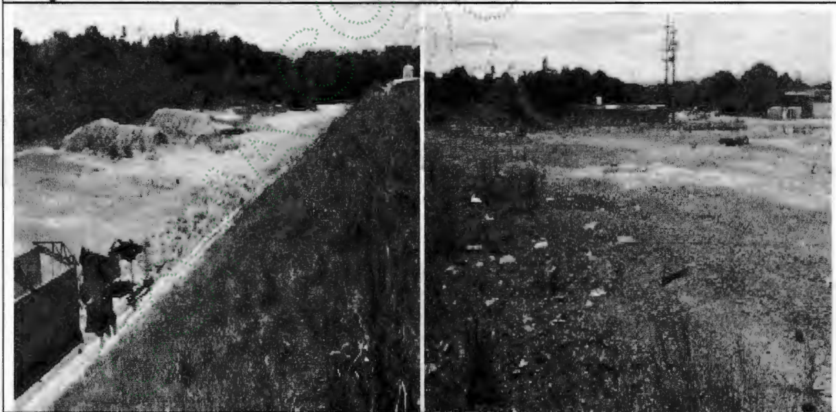
Imagen 2. Área donde se realizó el movimiento de tierra.
