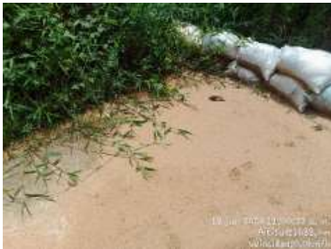
Fotografía 3. Sedimentos sobre el tanque de almacenamiento. Fuente: Cornare 2024
