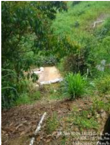
Fotografía 4. Tanque de almacenamiento vista desde el relleno. Fuente: Cornare 2024
