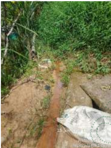
Fotografía 5. Cunetas colmatadas y alta cobertura vegetal. Fuente: Cornare 2024
