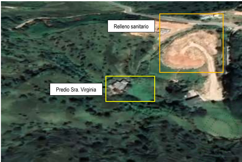
Figura 1. Relleno sanitario y predio afectado. Fuente: Google Earth, 2024
