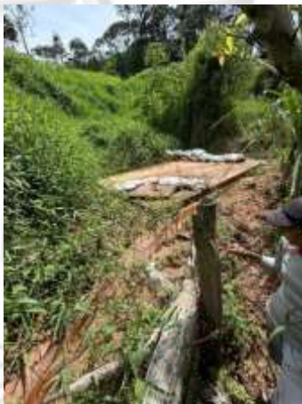
Fotografía 1. Tanque de almacenamiento y cuneta perimetral. Fuente: Cornare 2024
