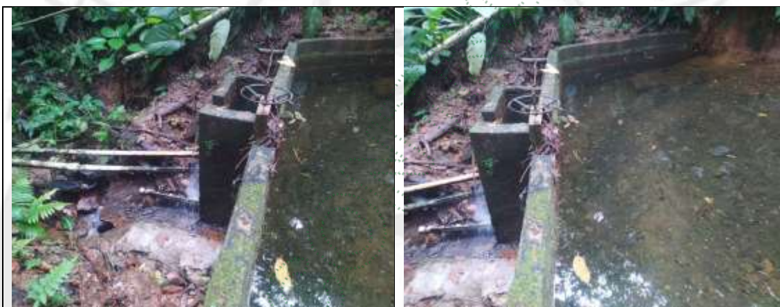
Figuras 1 y 2. Obra de captación en la Q. Caturral de los predios 1 al 5.
