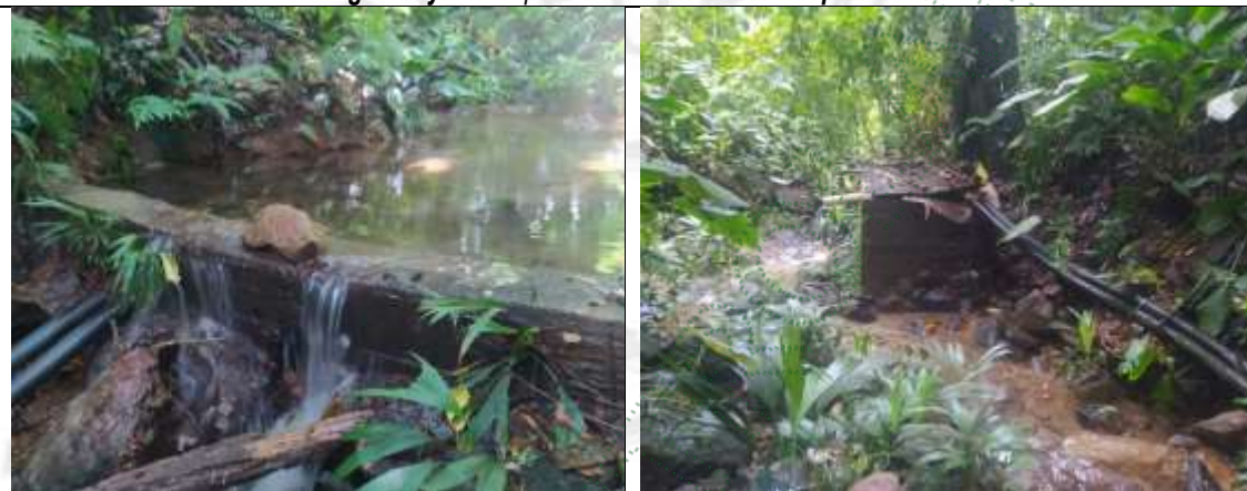
Figura 7. Bocatoma del predio 7.
