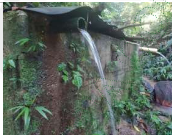
Figura 9. Tanque de abastecimiento y desarenador del predio 7.
