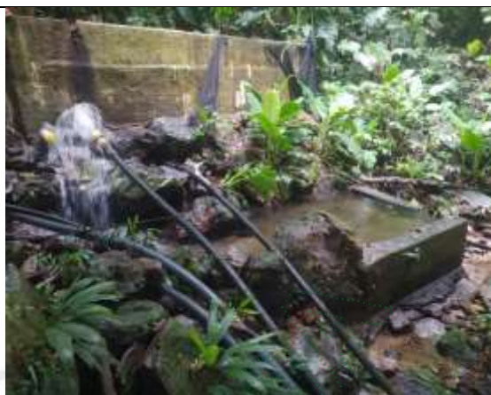
Figura 5 y 6. Tanque de almacenamiento del predio 6.
