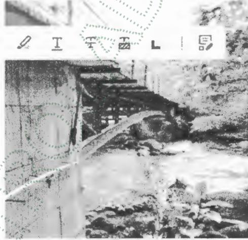
Imagen 4- Cercha metálica soporte de puente vehicular y apoyos laterales
