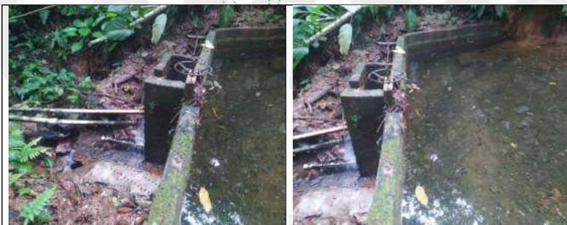
Figuras 1 y 2. Obra de captación en la Q. Catural de los predios 1 al 5.
