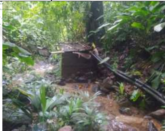
Figura 8. Tanque de abastecimiento y desarenador del predio 7.
