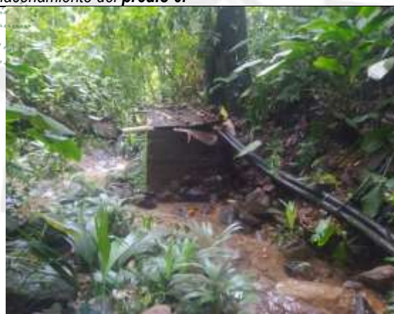
Figura 8. Tanque de abastecimiento y desarenador del predio 7.
